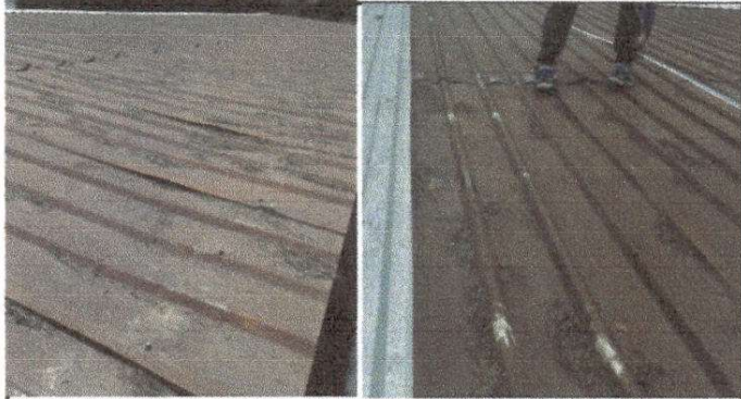
Foto 1: Sustitución de lámina por lámina troquelada Aluzinc, calibre 26. Un total de 332 M2.
