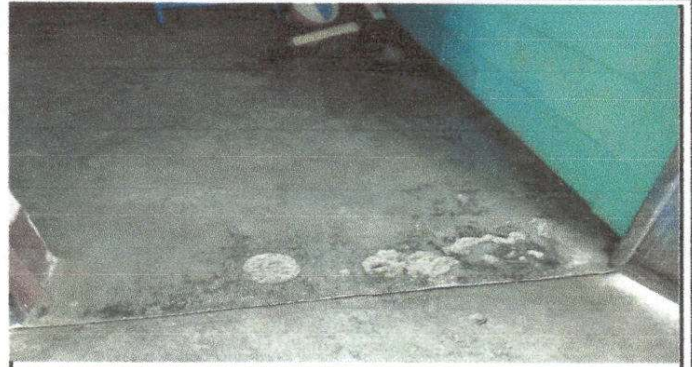
Foto 2: Sustitución de piso por piso granito, un total de 107 m2.
