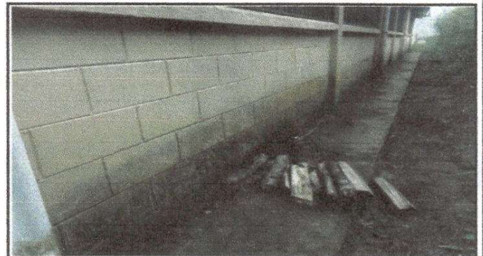
Foto 4: Pintura en muros exteriores e interiores con un total de 424 M2..
